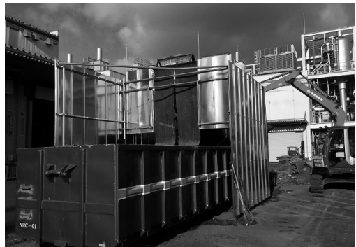
コンテナへの積み込み作業
