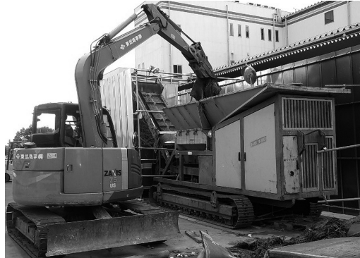
破碎機処理作業。破碎機からコンベアを介してコンテナに送られる
