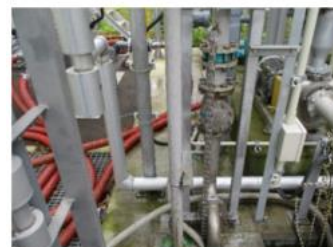
【洗浄水槽施設】
